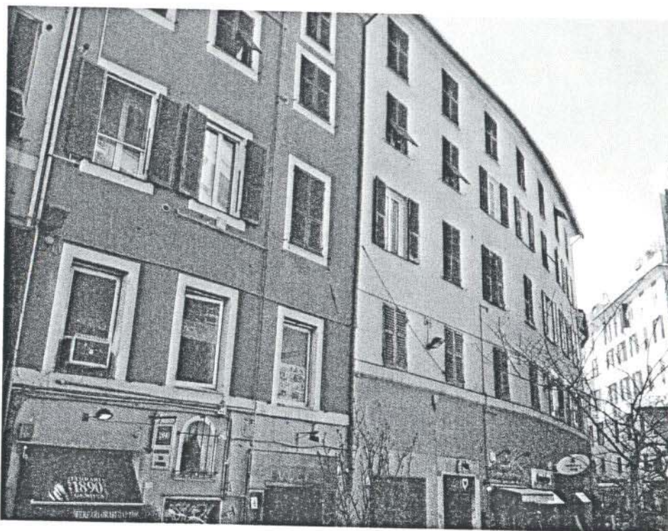
Foto 1 - Palazzata esistente a SUD di Via San Vincenzo antistante l'edificio oggetto di osservazione
