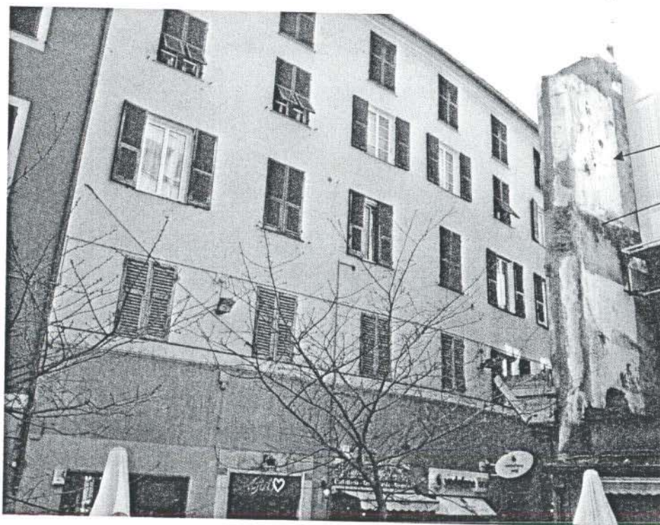
Foto 2 - Palazzata esistente a SUD di Via San Vincenzo antistante l'edificio oggetto di osservazione
